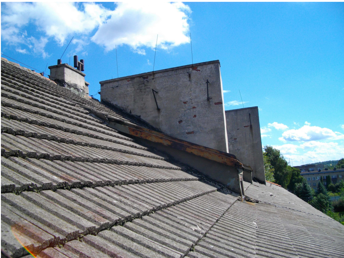
Fot. 4 Widok połaci dachowych budynku przy ul. Mickiewicza 11 w Mikołowie
