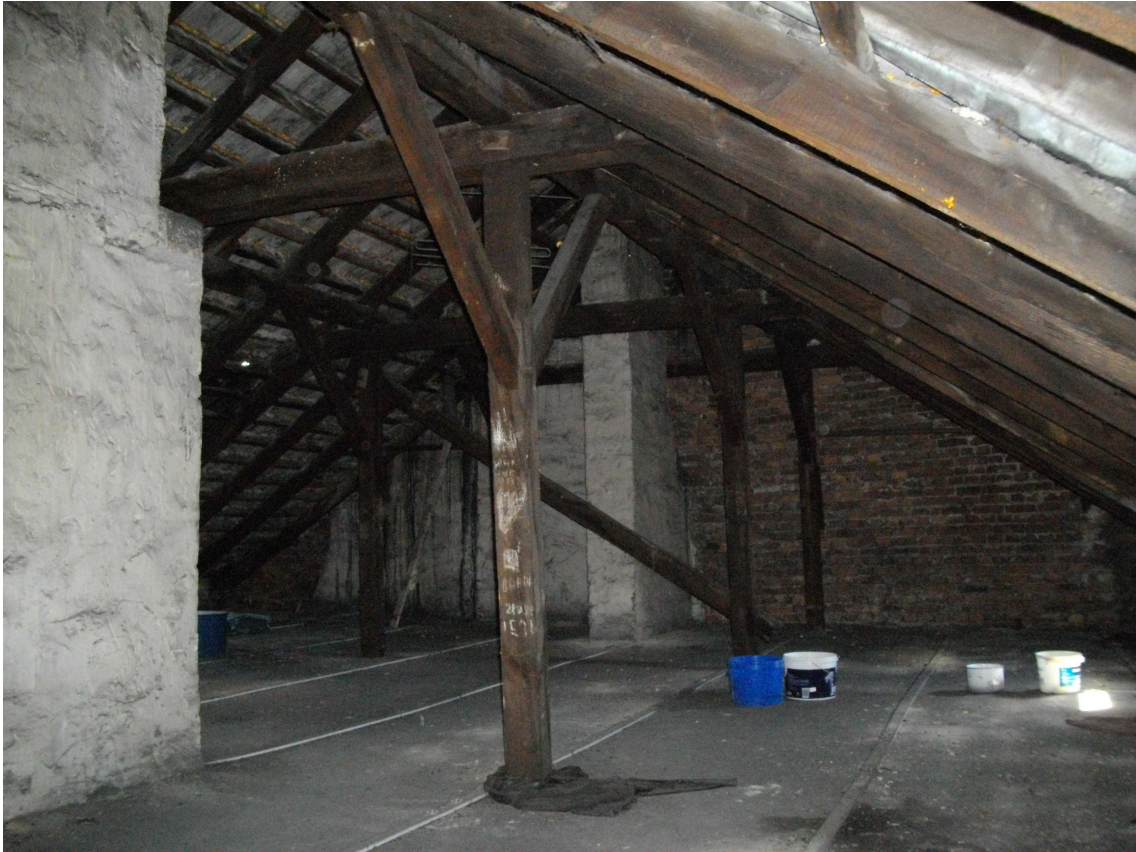
Fot. 3 Konstrukcja więźby budynku przy ul. Mickiewicza 11 w Mikołowie
