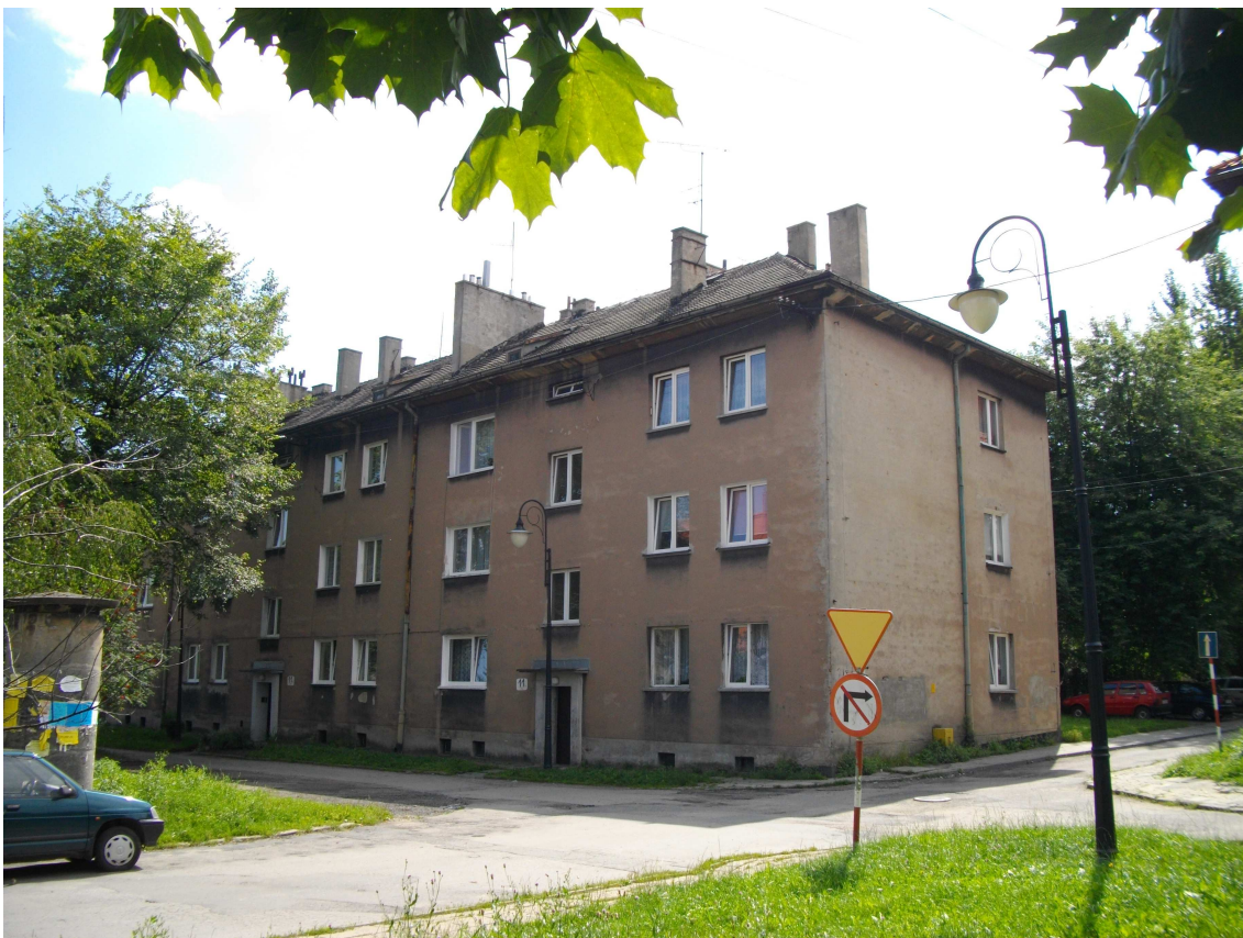
Fot. 1 Widok budynku na os. Mickiewicza 11 od strony północno-zachodniej
