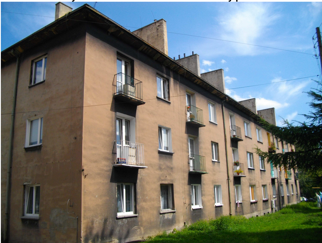
Fot. 2 Widok budynku na os. Mickiewicza 11 od strony południowo-zachodniej
