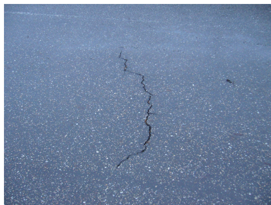
Spękania nawierzchni
