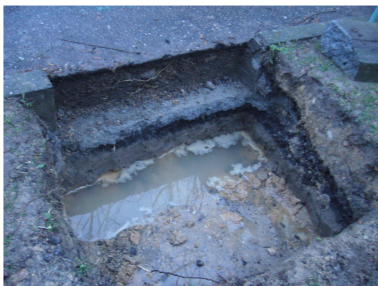
Podbudowa boiska asfaltowego
