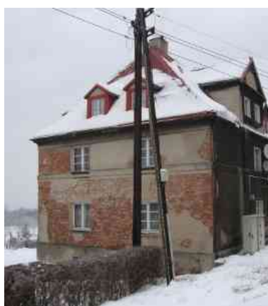
Fot.3 Elewacja boczna I – zachodnia.
