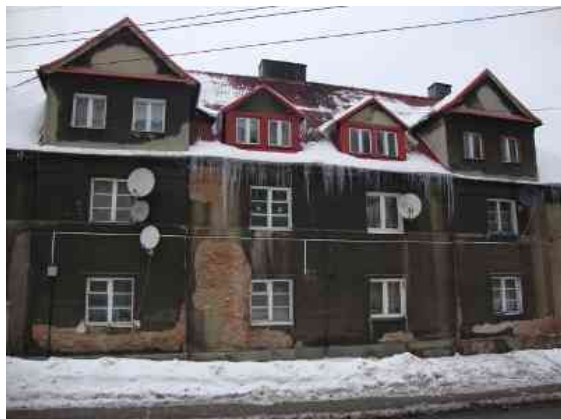
Fot.1 Fragment elewacji frontowej – południowej.
