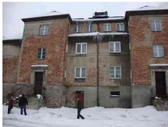
Fot.2 Fragment elewacji tylnej – północnej.
