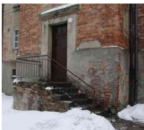
Fot.5 Schody wejściowe do budynku.
