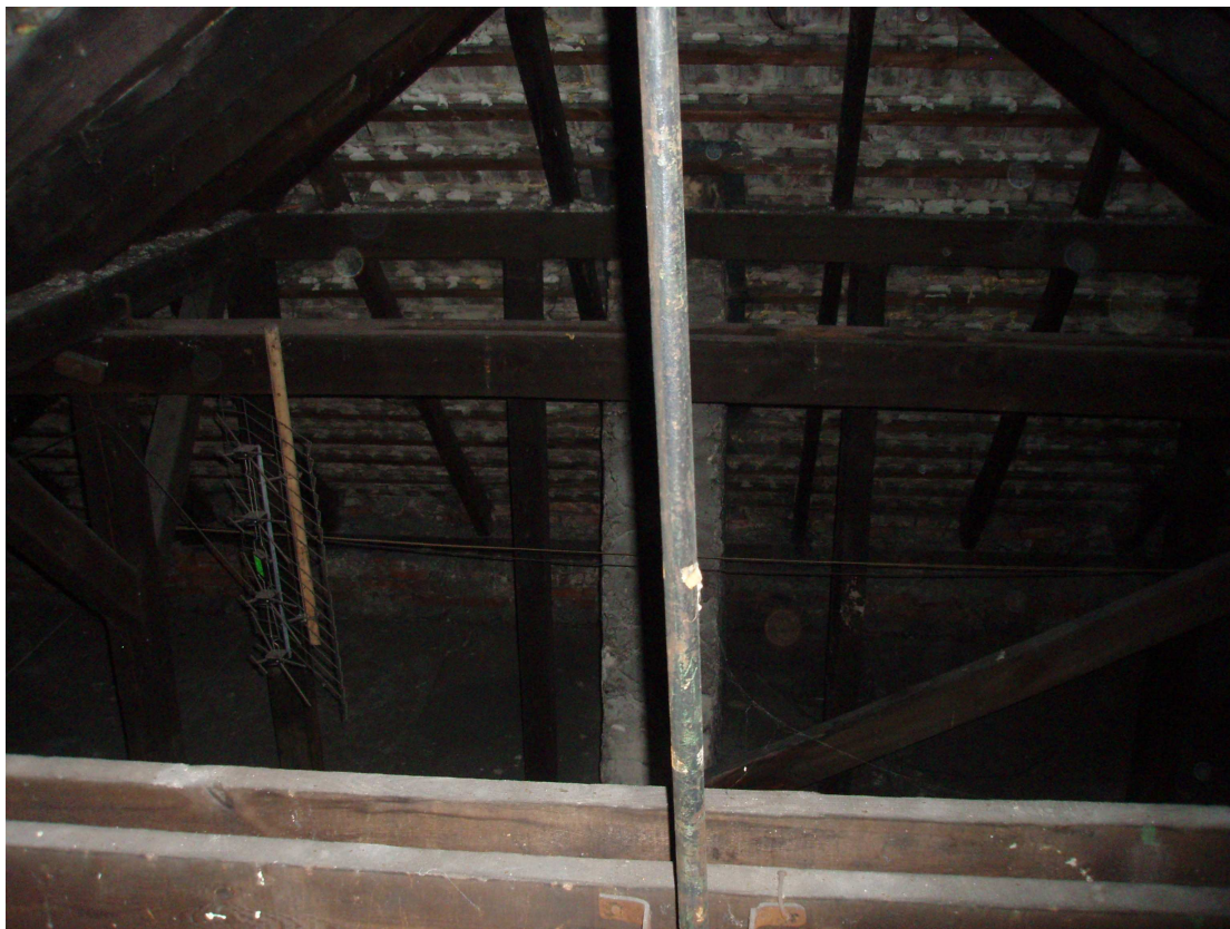
Fot. 2 Widok więźby budynku na os. Mickiewicza 15 w Mikołowie
