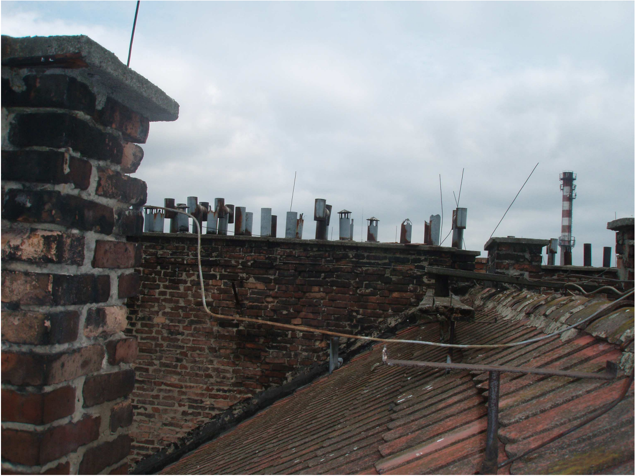
Fot. 3 Widok połaci dachu budynku na os. Mickiewicza 15 w Mikołowie
