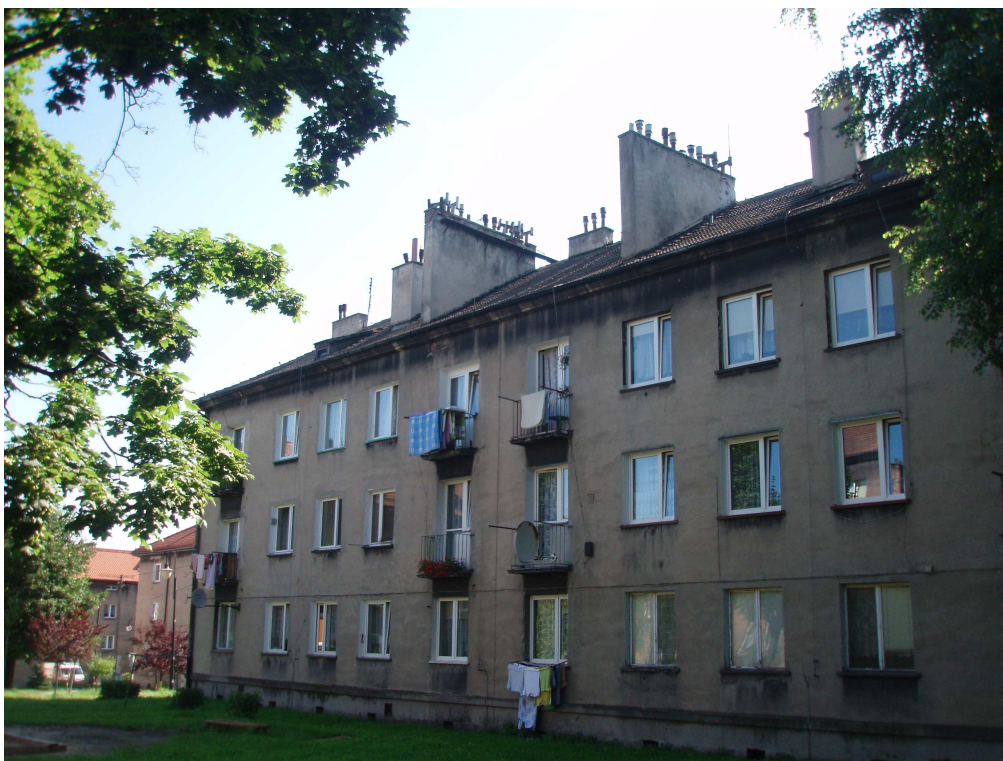
Fot. 2 Elewacja tylna budynku przy ul. Mickiewicza 13 w Mikołowie
