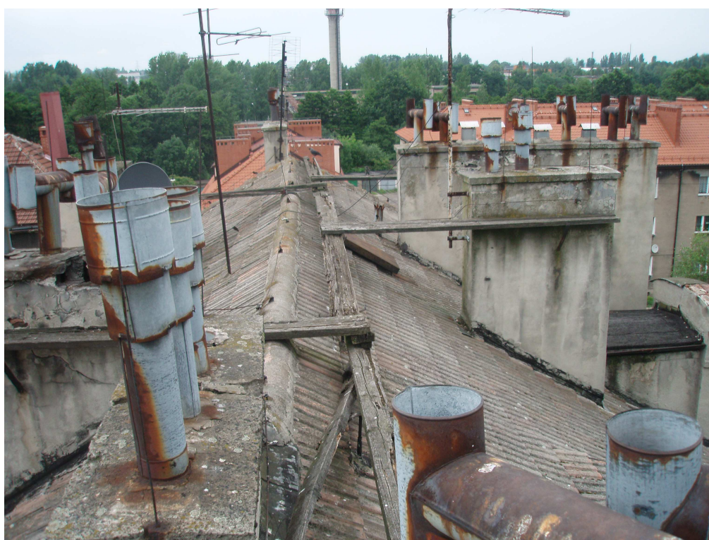
Fot. 4 Widok połączenia dachowych budynku przy ul. Mickiewicza 13 w Mikołowie
