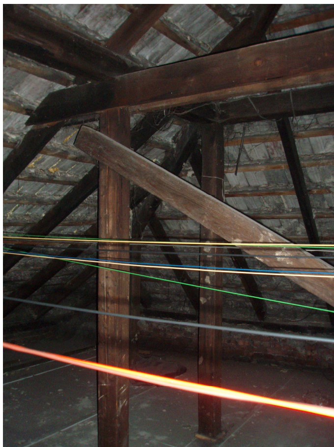
Fot. 3 Konstrukcja więźby budynku przy ul. Mickiewicza 13 w Mikołowie
