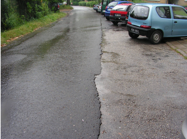
Zdj. nr 5 Liczne nierówności masy; niejednorodność materiałowa
