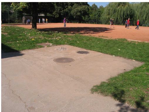
OBIEKT NR 3 komora osadnikowa
