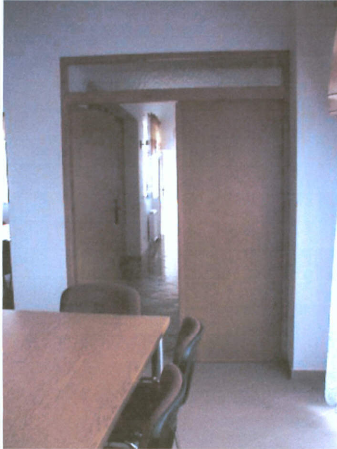
Fot. 2 Przejście do kuchni, w którym należy zabudować drzwi z naświetlem.
