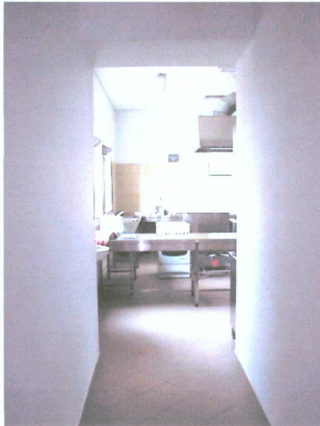
Fot. 2 Przejście do kuchni, w którym należy zabudować drzwi z naświetlem.
