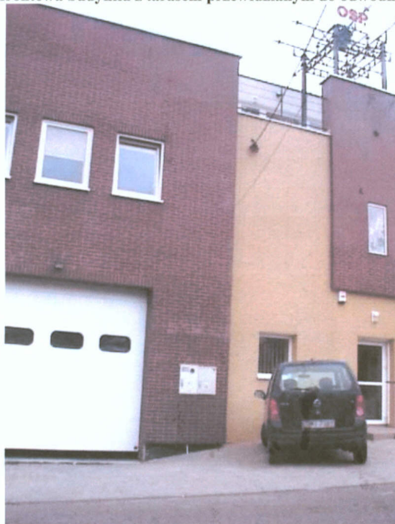
Fot.5 Elewacja frontowa budynku z tarasem przewidzianym do odwodnienia.
