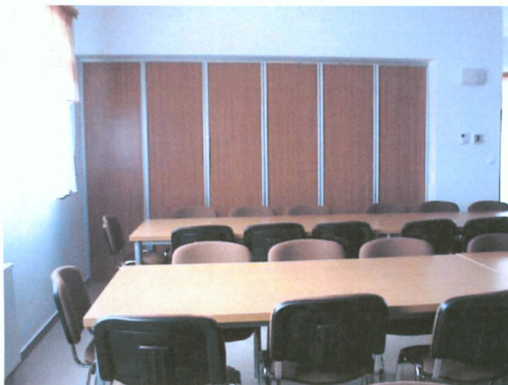
Fot. 4 Drzwi harmonijkowe zamknięte– fotografia wykonana od strony przewidzianej do zabudowania rygla (blokady).
